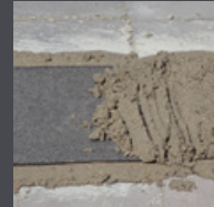
Pose d'un feutre bitumineux entre deux couches de mortier
