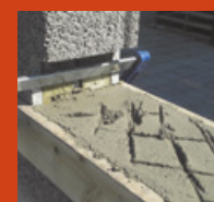
Lit de mortier coffré pour la pose de l'appui
