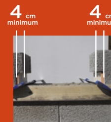
Isolant polyuréthane de part et d'autre de l'appui
