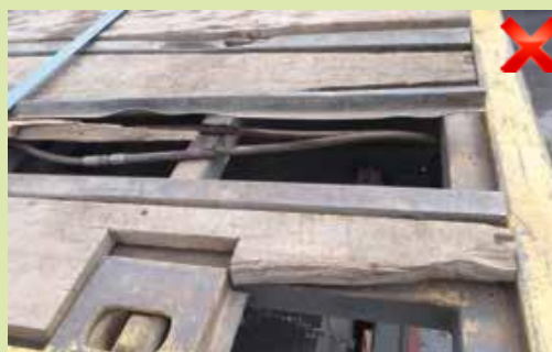
laadvloer in slechte staat
