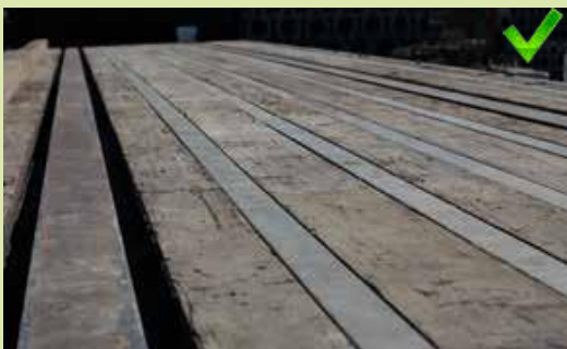
Plancher de chargement en bon état
