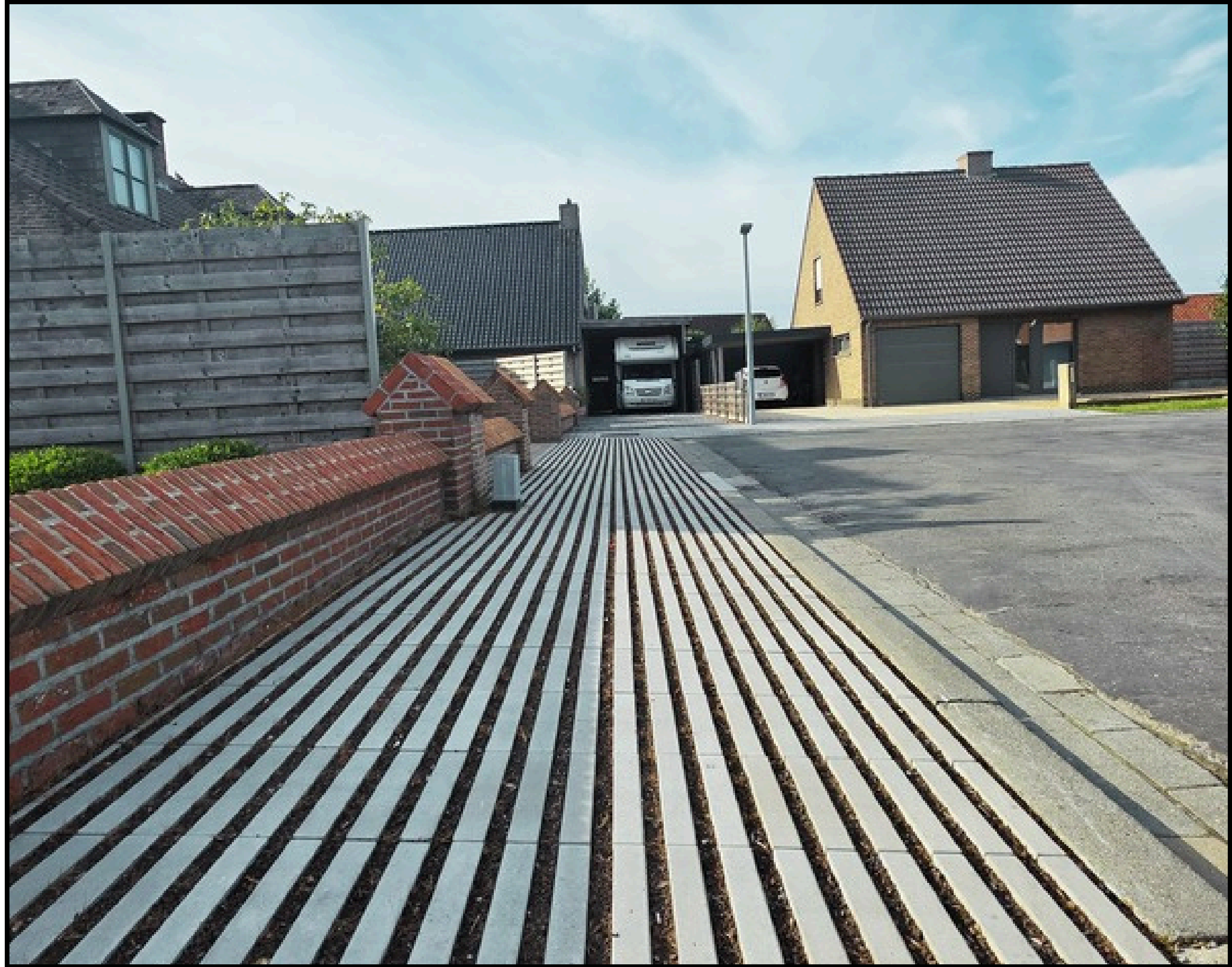
Project LinO'green Ingelmunster- Vinkenstraat
