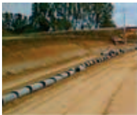
Tuyaux bardés sur chantier
