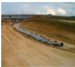
Tuyaux bardés sur chantier
