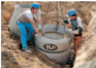
Installation d'un regard sur chantier
